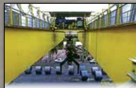
Подъем мостового крана Lifting of the empty hook bridge crane
